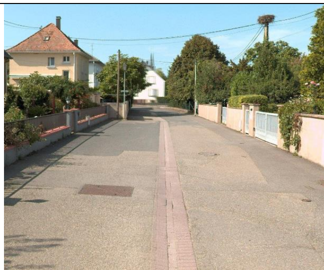
N°4 : photo de la rue du foyer
