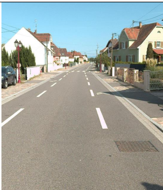
N°1 : photo de la rue de Lingolsheim
