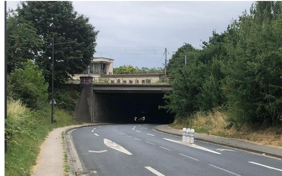
Chaussée à voie centrale banalisée Rue de la Villette
