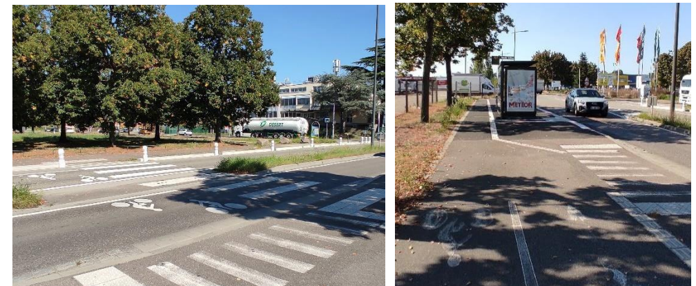
Discontinuité des aménagements cyclables Rue du Marché Gare
