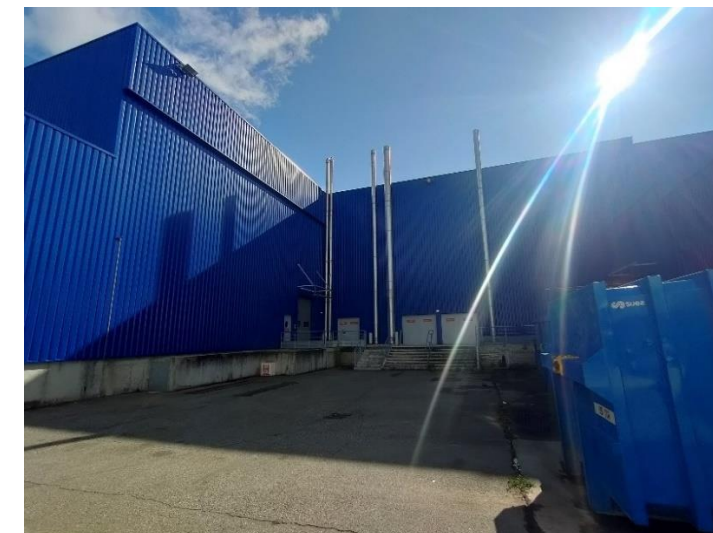
Figure 25 : Façades du bâtiment sans aspérités notables, T. POBLET © EODD, 2023
