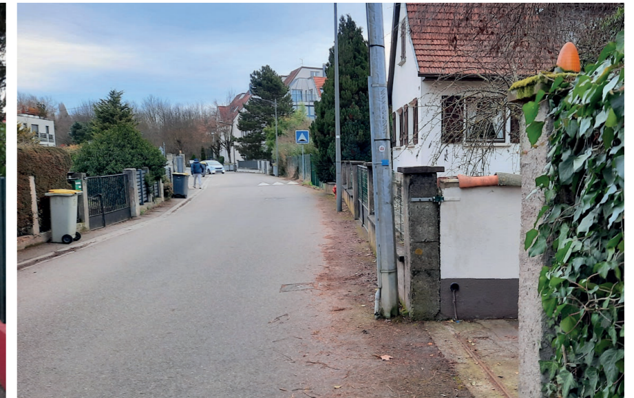
2 Séquence est, chaussée de largeur 6m sans trottoir, vitesse limitée à 30km/h.
