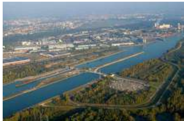
Barrage hydroélectrique sur le Rhin
