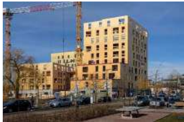
Construction Bois au sein du quartier du Port du Rhin
