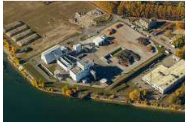
Chaufferie collective biomasse du Port du Rhin
