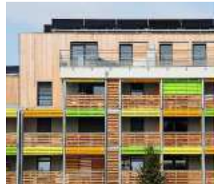
Installations de production énergétique sur toiture
