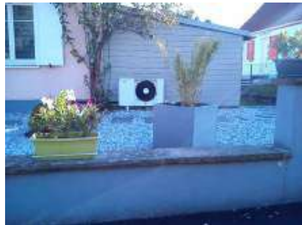
Habitation avec espace vert remplacé par une minéralisation intégrale et disposant d'un climatiseur
