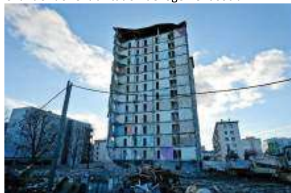
Chantier de démolition / reconstruction
