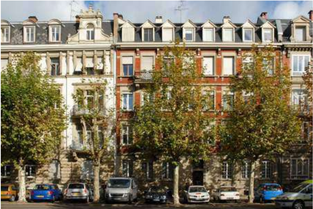
Typologie bâtie au niveau de l'avenue des Vosges à Strasbourg – ADEUS
