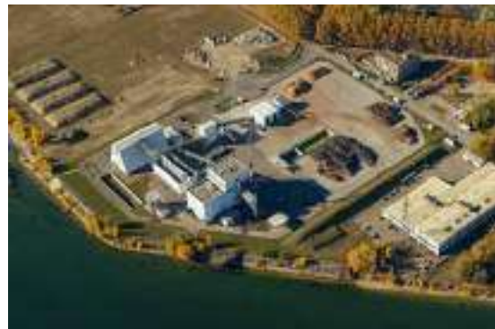
Chaufferie bois du Port du Rhin
