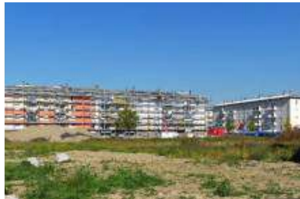
Chantier de réhabilitation de logement social
