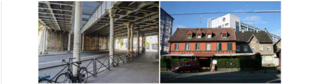
Poste d'aiguillage et voie ferrée datent de 1905 – Le pont prend le nom de l'usine de sucreries rachetée par Suchard en 1965 – La ligne A du tram est mise en service en 1994 (Doc Archi-Strasbourg – Photos Quentin Bonvalot et MM)
