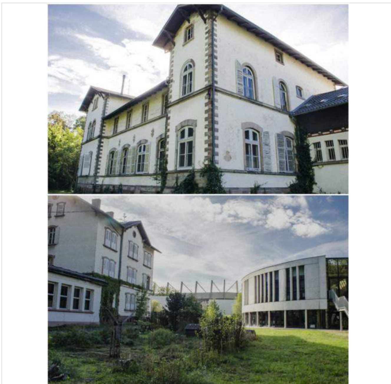
Ancien et nouveau bâtiments de l'École d'instituteurs, avec vue sur les arcs stade et jardin partagé (Photos Quentin Bonvalot)
