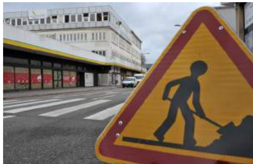
Le bâtiment de l'ancien supermarché Simply sera détruit fin janvier.
