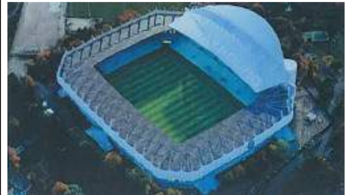
L'esprit du projet est d'ajouter des étages supplémentaires à la tribune sud de la Meinau. Ici une vue, non définitive, extraite d'une étude de faisabilité du cabinet Catevet. DR
