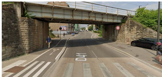
Passage sous la voie ferrée de la route d'Oberhausbergen (prise de vue vers l'Ouest)
