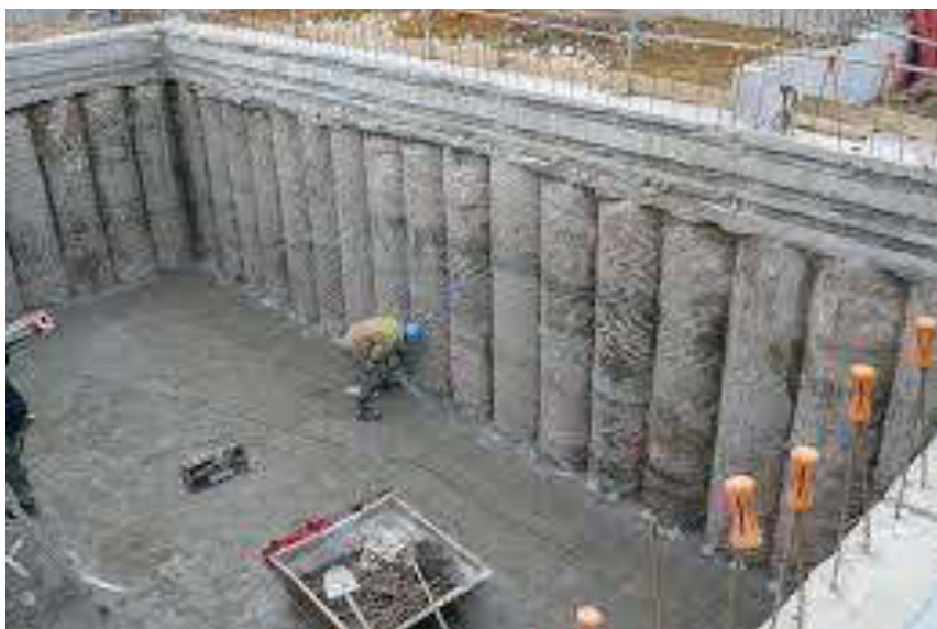
Exemple de terrassement à l'intérieur d'un rideau de pieux sécants
