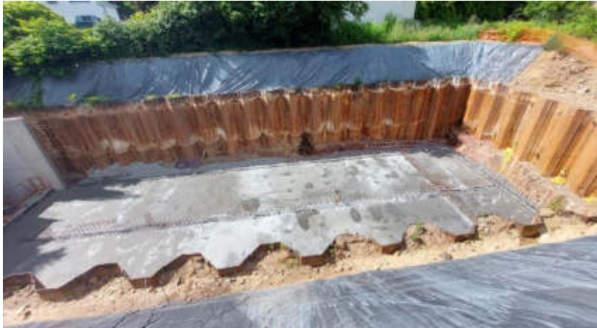
Exemple de fouilles soutenues par des palplanches
