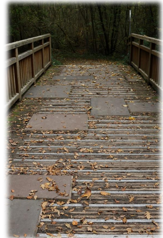
Entretien des infrastructures Exemple de la passerelle des Dames
