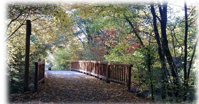
Passerelle paysagère – chemin du chat sauvage
