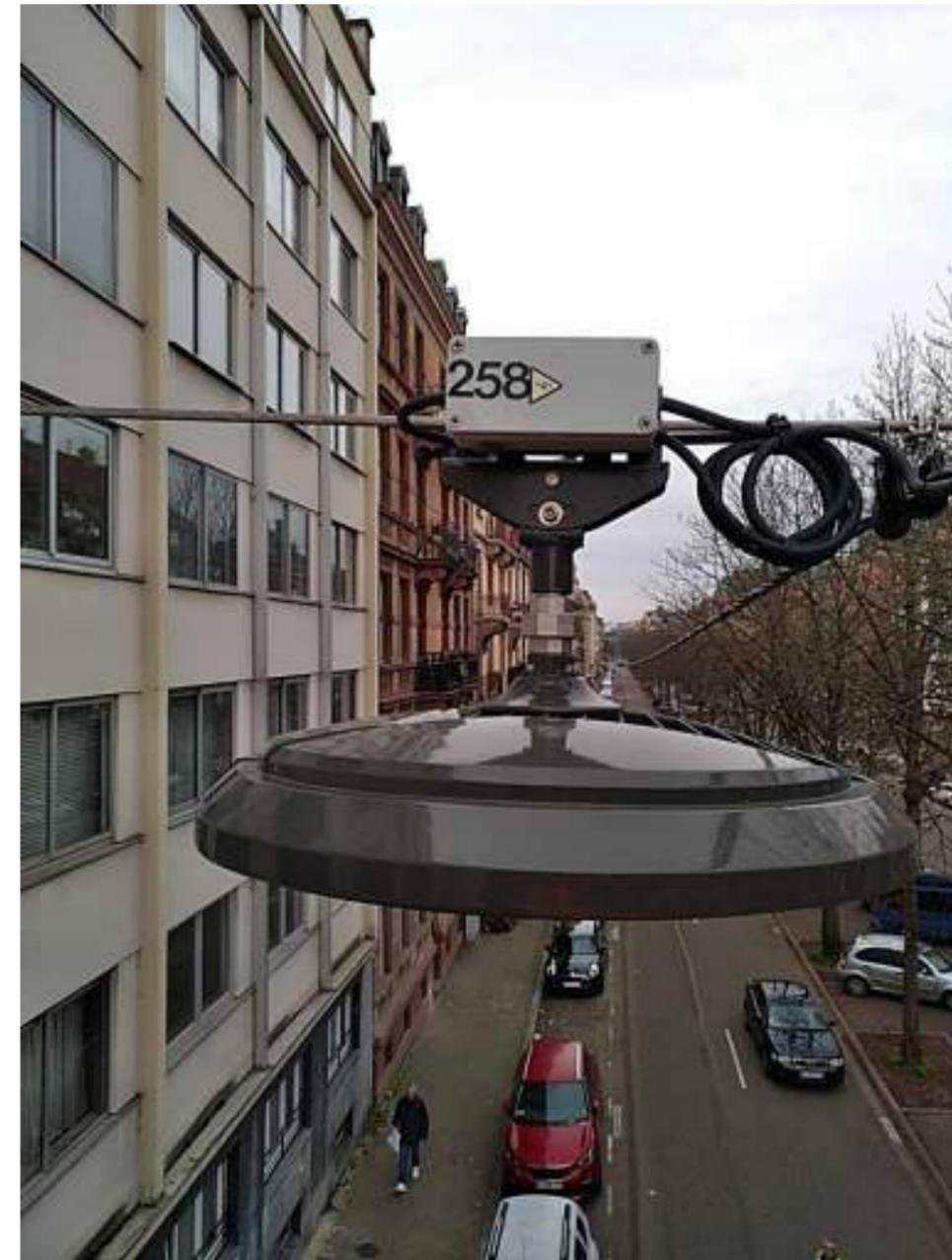
Vue du luminaire sur la caténaire et du réseau électrique aérien
