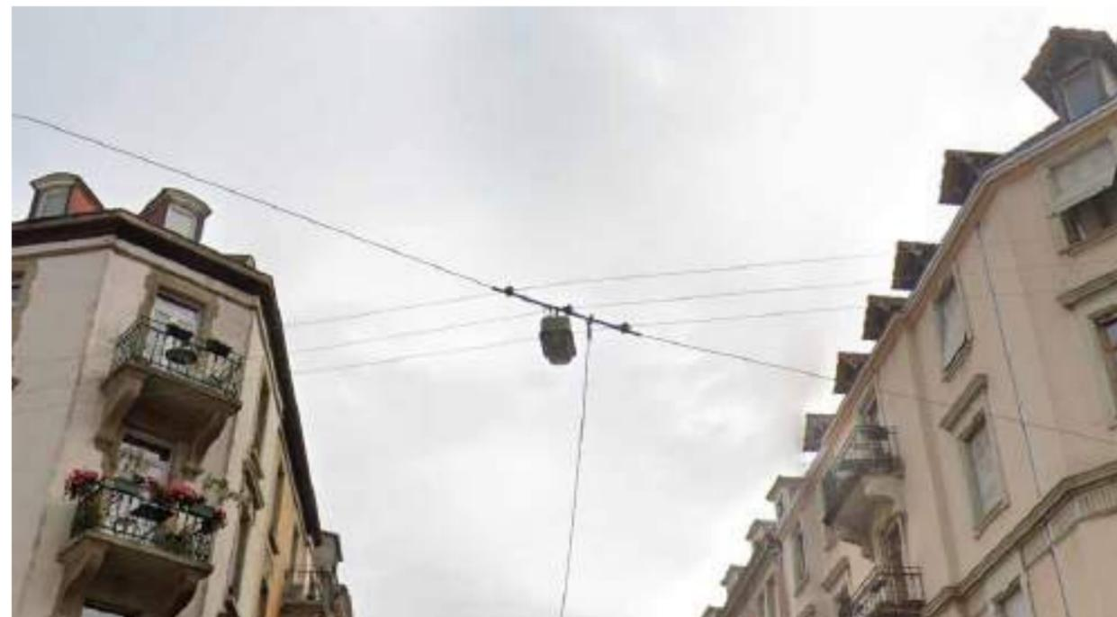
Rue du Général Rapp : Luminaire avec ancrage simple
