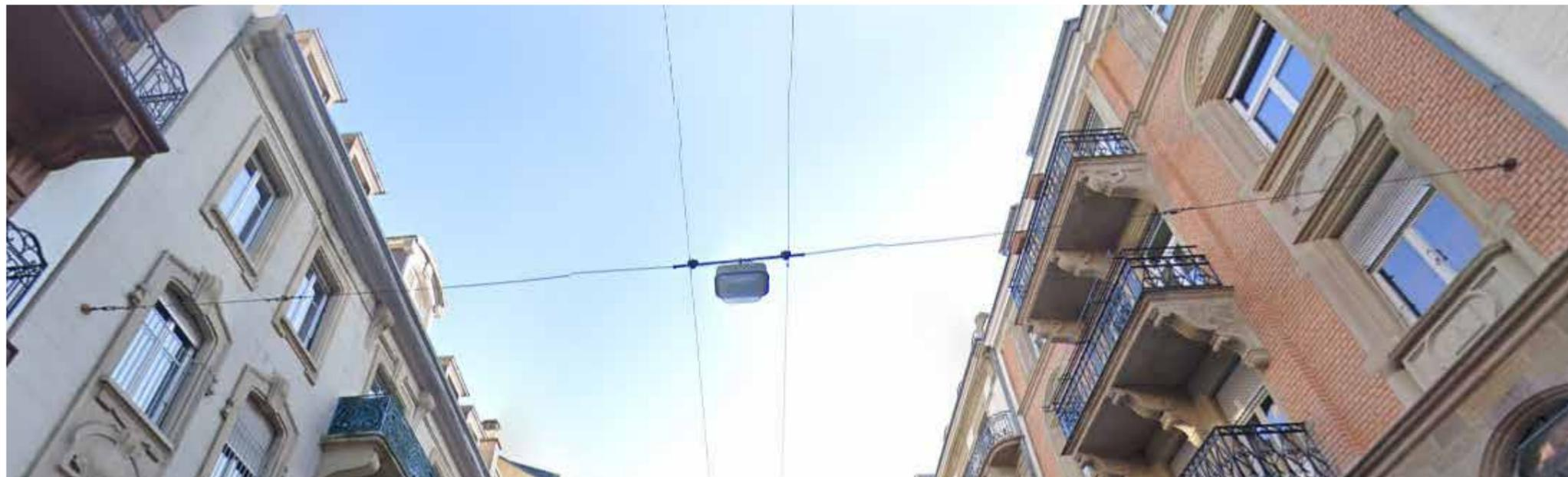
Rue du Général Rapp : Luminaire avec ancrage simple
