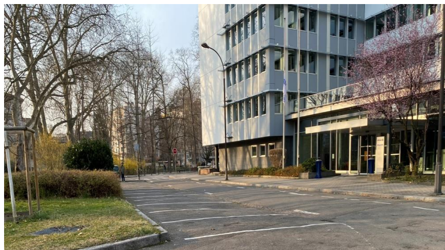
Parking au devant du 1 rue des Arquebusiers
