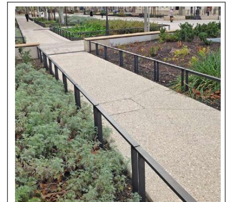
Protection des espaces-verts avec lisse métallique basse dans la longueur et petits enrochements face aux zones de recul des véhicules
