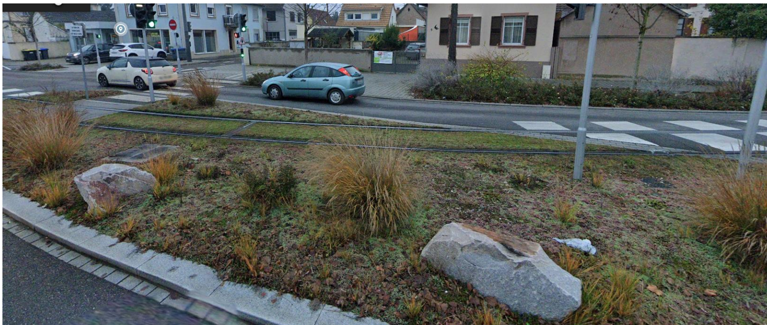
Les rochers anti-franchissement
