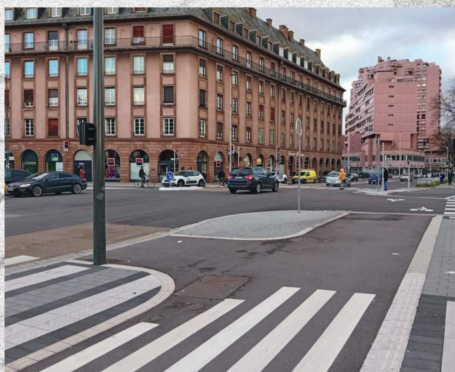
Séparation piéton-vélo et traversée Strasbourg
