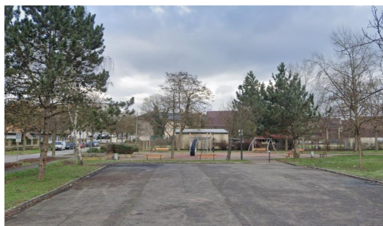
Parking square de la Breitlach
