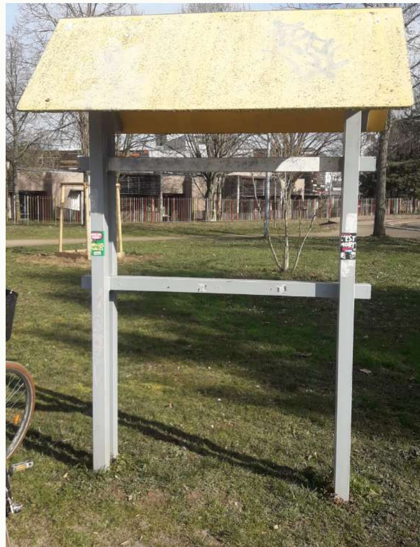
Derrière le CSC, sur l'existant
